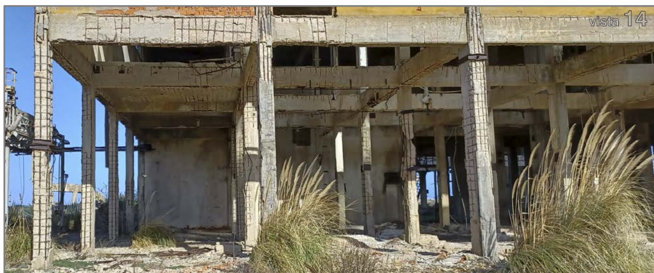
Vista 14 - Area ex TPF: Piano terra Fabbricato TPF (è evidente lo stato di estremo degrado della parti strutturali in cemento armato)
